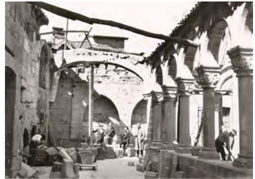
FIG. 2 Obras de restauro do claustro da Colegiada de Nossa Senhora da Oliveira, 1928-1935. © MAS.
