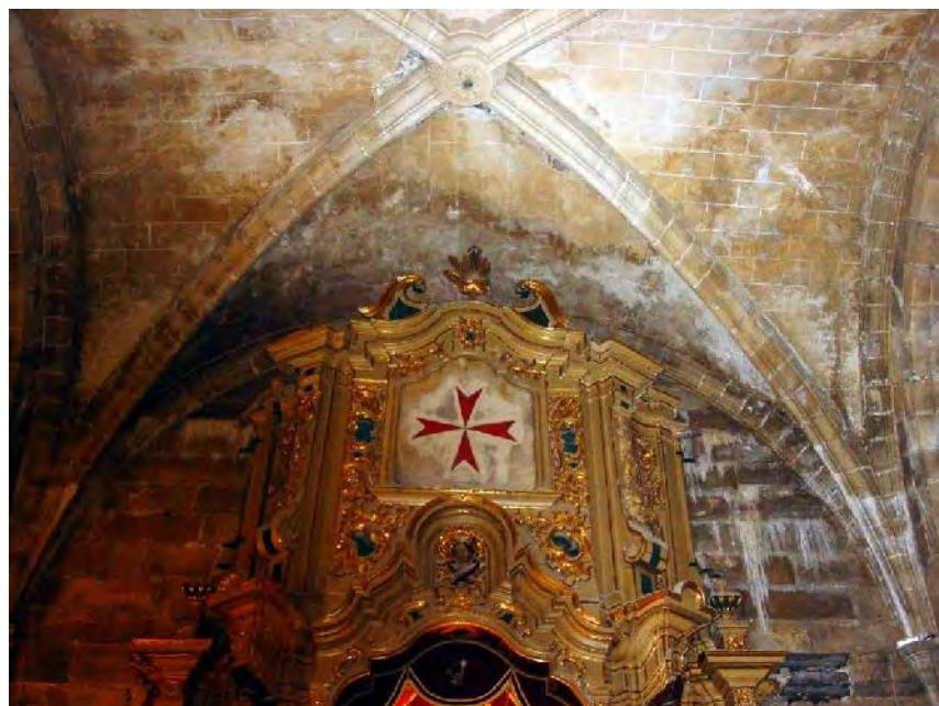
**Fig. 4** - Detalle del ático del Retablo de Nuestra Señora de Belén. Catedral de Jerez de la Frontera. Son visibles las manchas de humedad y las eflorescencias salinas consecuencia de las infiltraciones de humedad procedentes de la cubierta y de los sistemas de evacuación de aguas pluviales que influyen negativamente en los elementos de madera existentes en su reverso, 2014.
