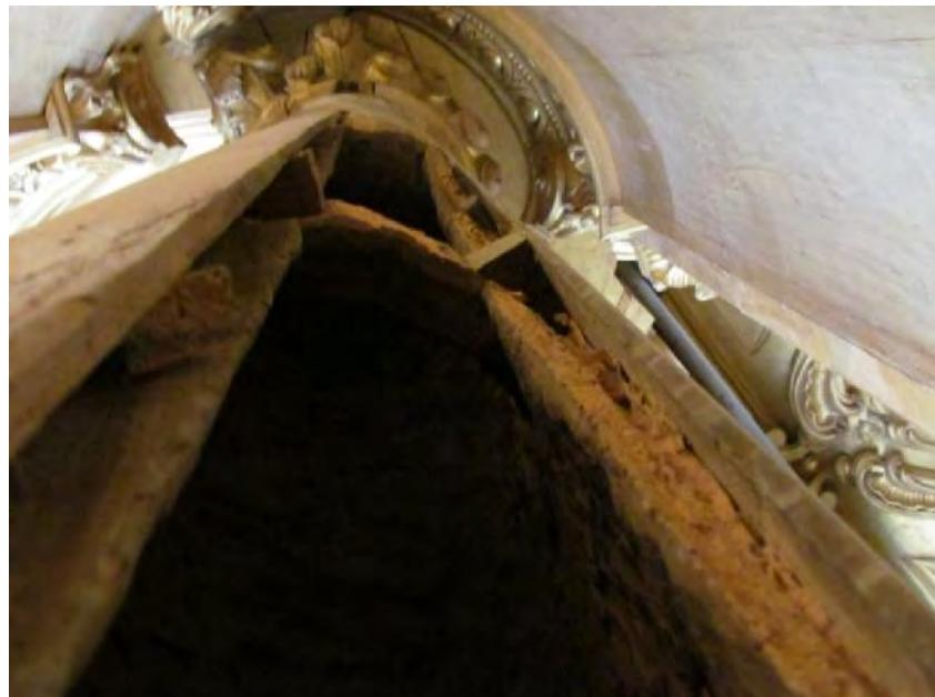
**Fig. 5** - Reverso de coluna (verificação de duplo tabuado) com vestígios bem visíveis da acção de xilófagos (lado da Epístola).
