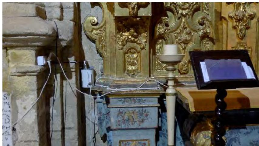
**Fig. 3** - Detalle de la instalación eléctrica anclada en la estructura del retablo. Obsérvese la disposición del hervidor de agua de uso habitual. Iglesia de Santo Domingo. Sanlúcar de Barrameda, Cádiz, 2015.
