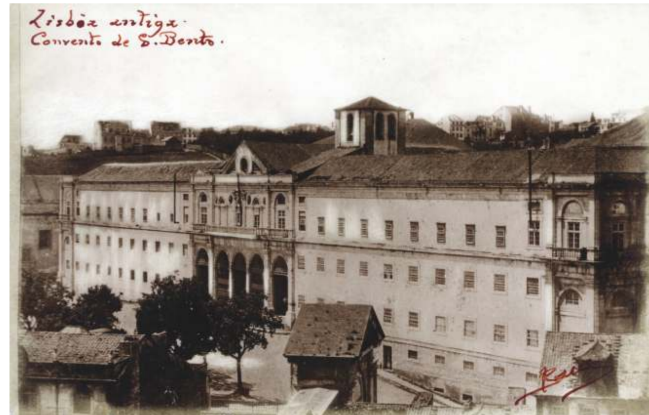
O Palácio das Cortes em 1875 AHP
