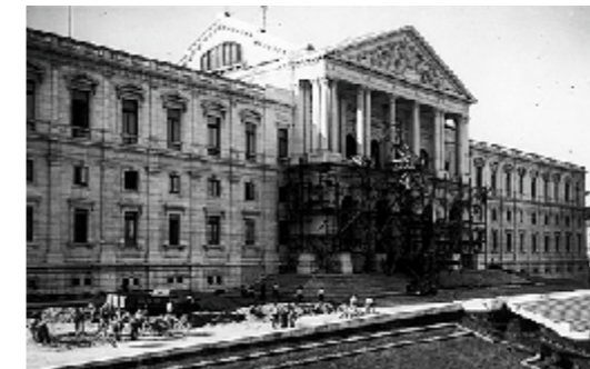
O Palácio da Assembleia Nacional em obras de remodelação do corpo central da fachada principal c. 1937-1938 AHP
