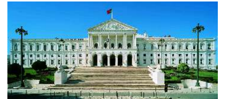
O Palácio de São Bento na atualidade AHP
